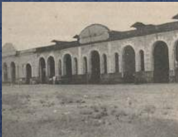
Figura 12: Antiga oficina da ferrovia Belém-Bragança (Marituba)
