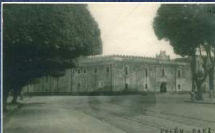
Figura 9: Antigo prédio do Presídio São José – primeiro quartel da Cavalaria
