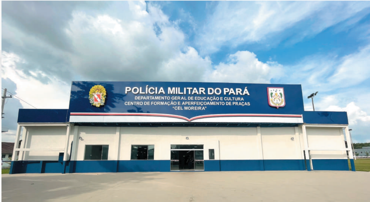
Prédio anexo do CFAP, 2021.
