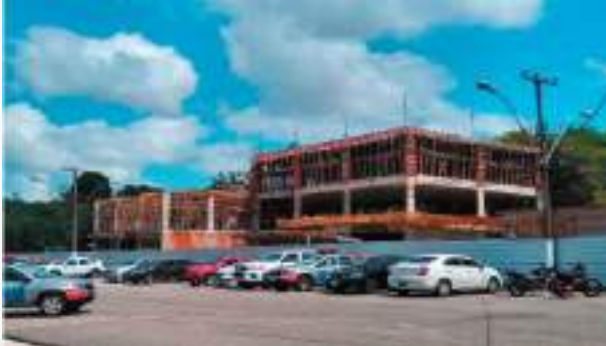
Construção do Complexo DGP.
