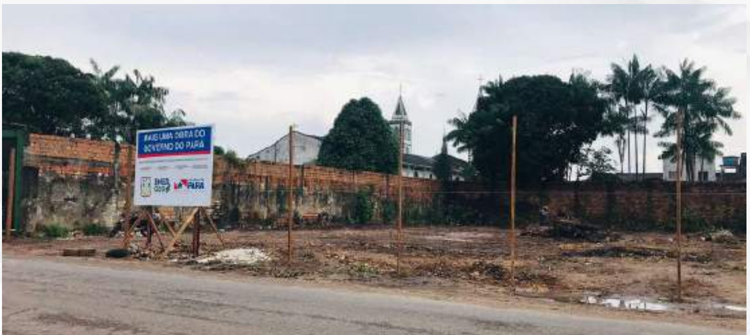
Área de construção do 6º BPM.
