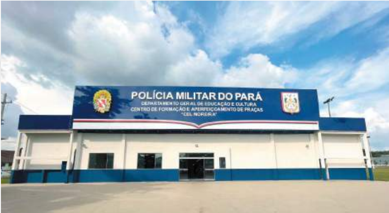
Prédio anexo do CFAP, 2021.
