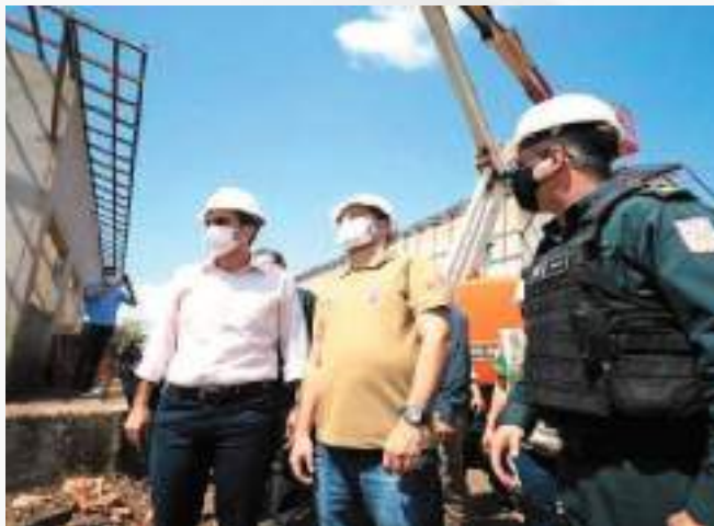
Visita do Secretário de Segurança Pública e do Governador às obras da Unidade Integrada de Segurança Pública em Marabá.
