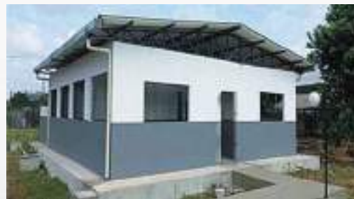
Detalhe da fachada da maternidade canina.
