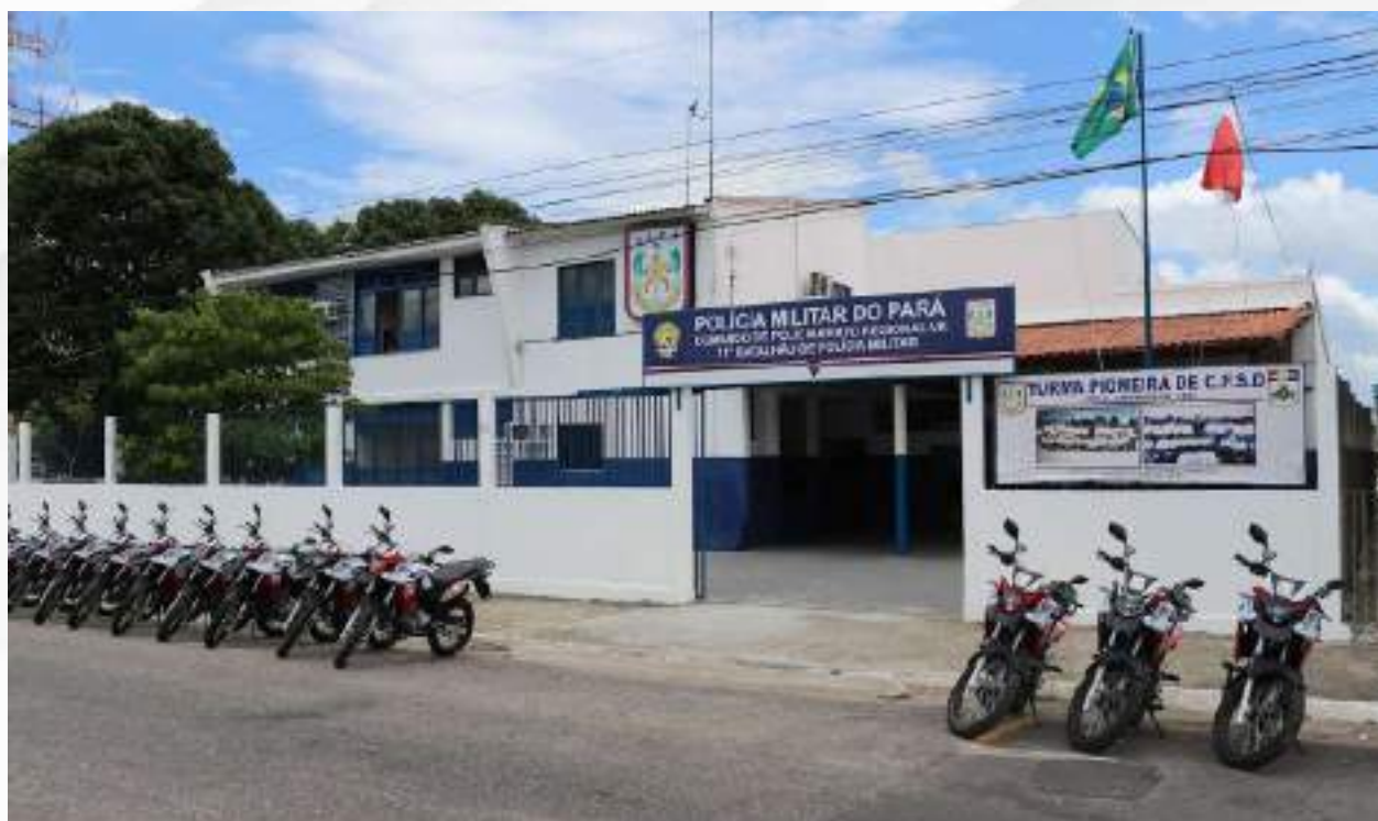
Prédio reformado do 11º Batalhão de Polícia Militar - CPR VII (Capanema).
