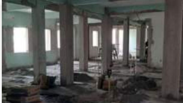
Execução da obra do HPM.
