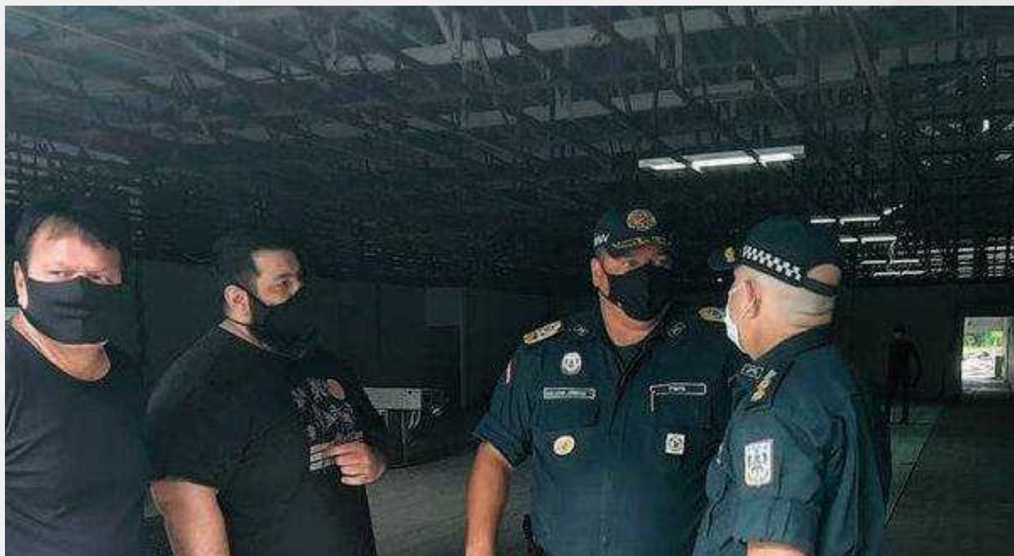
Coronel PM Dilson Júnior inspeciona obras de reforma do Centro de Formação e Aperfeiçoamento de Praças (CFAP), em Belém.
