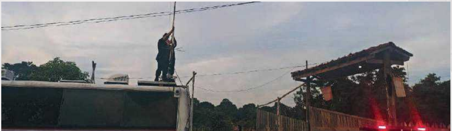
Instalação de estação de rádio no município de Cametá, 2020.
