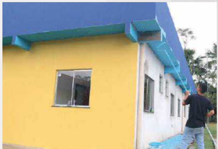
Novo prédio do CVP iniciado em 2020, atualmente em fase de acabamento.
