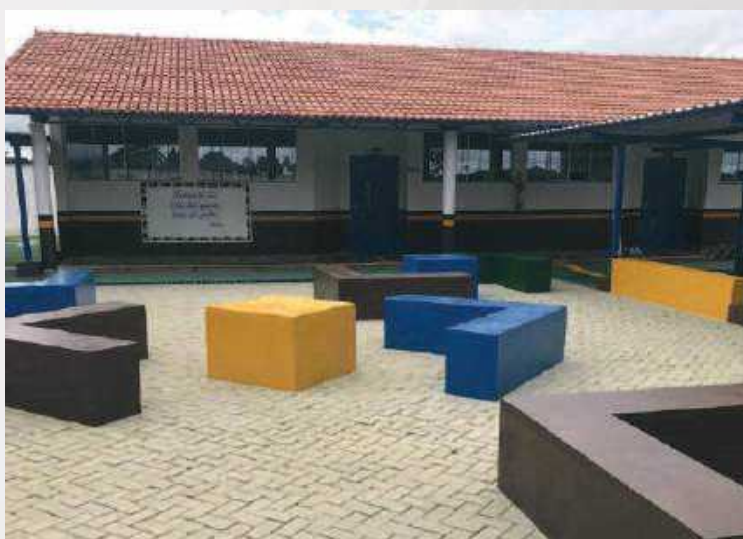
Vista do pátio interno da Escola Ronildo Aridal, 2019. Fonte: ASCOM PMPA
